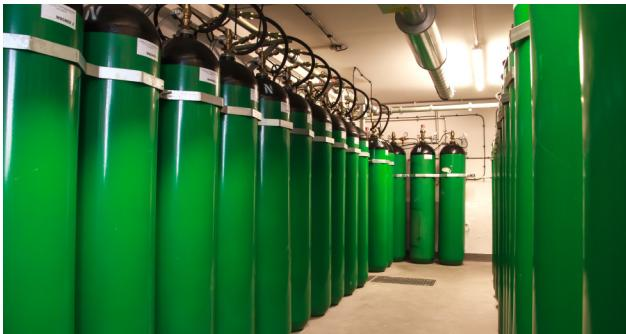
*Im äußersten Fall: Hochdruck-Inertgas-Löschanlage*
