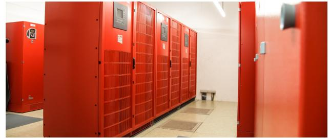
Unterbrechungsfreie Stromversorgung: USV-Anlagen (rot)
