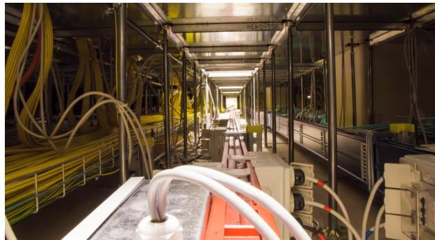
*Luftzuführung, Kühlung und Kabeltrassen im Doppelboden*
